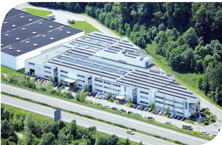
Le siège social de EWS implanté à Uhingen en Allemagne.
