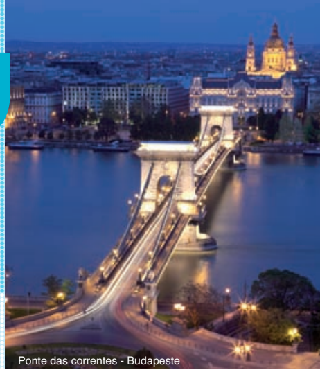
Ponte das correntes - Budapeste
