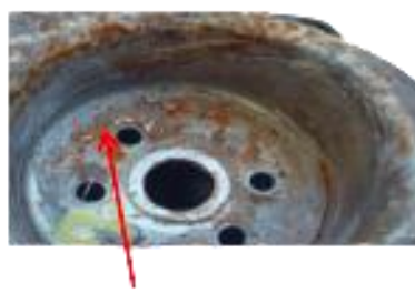
Korozja spowodowana przez ruch sprężyny
