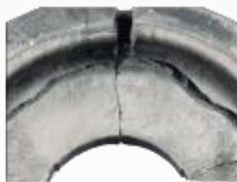
Uszkodzone łożysko amortyzatora Pęknięte gniazdo łożyska amortyzatora
